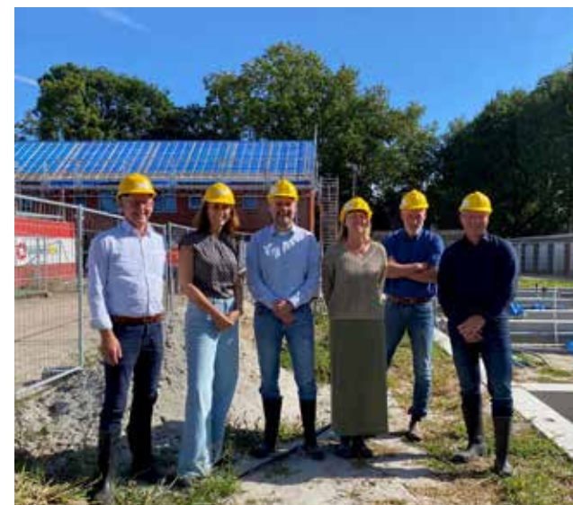
Op 29 augustus bezocht de Raad van Commissarissen de bouwplaats aan de Emmastraat.
