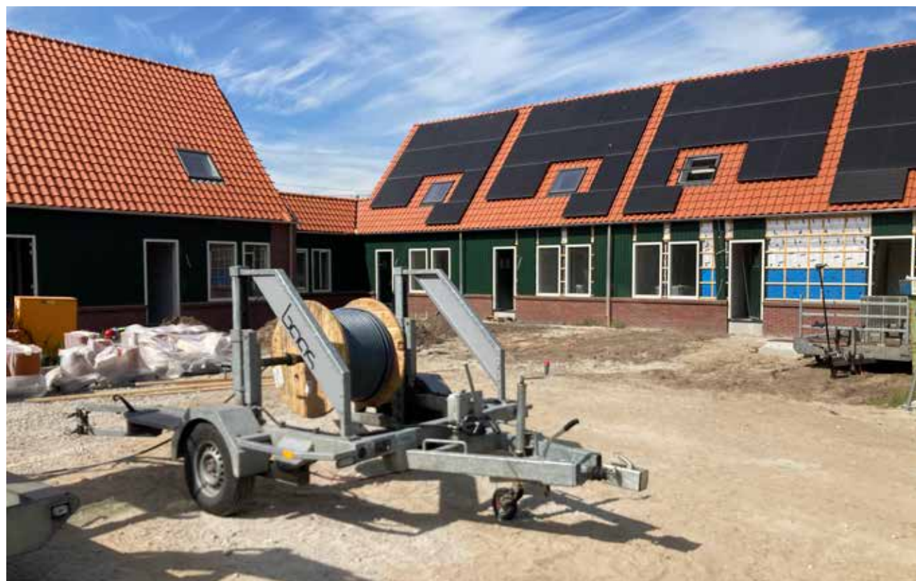
De gevelafwerking van de voorgevels wordt zichtbaar (foto eind augustus).
